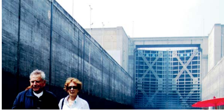
Foto 6 - Sanxia barajı gemi geçidinde bir havuz kademesinin içi (Foto: C.Jiang)
