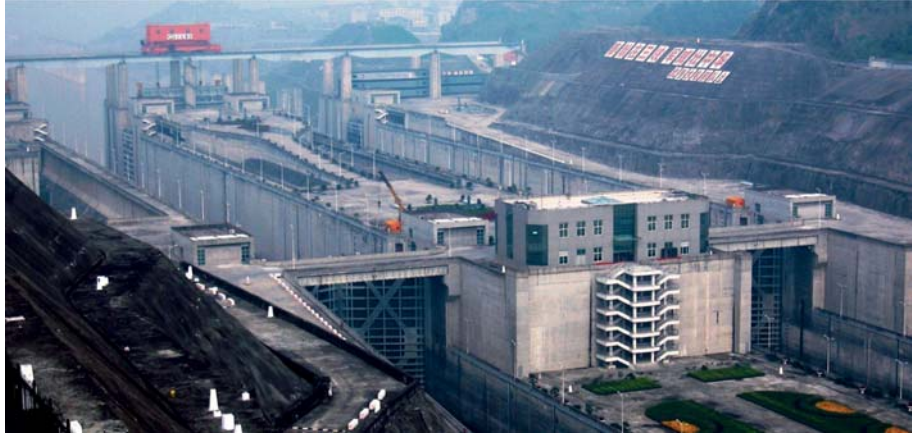
Foto 5 - Sanxia barajı gemi geçidinin üst kesiminde havuzlar (Foto: Ü.Öziş).
