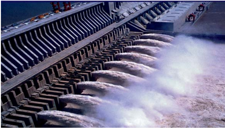
Foto 3 - Sanxia barajı dolu ve dip savakları (Foto: C.T.G.P.C.).
